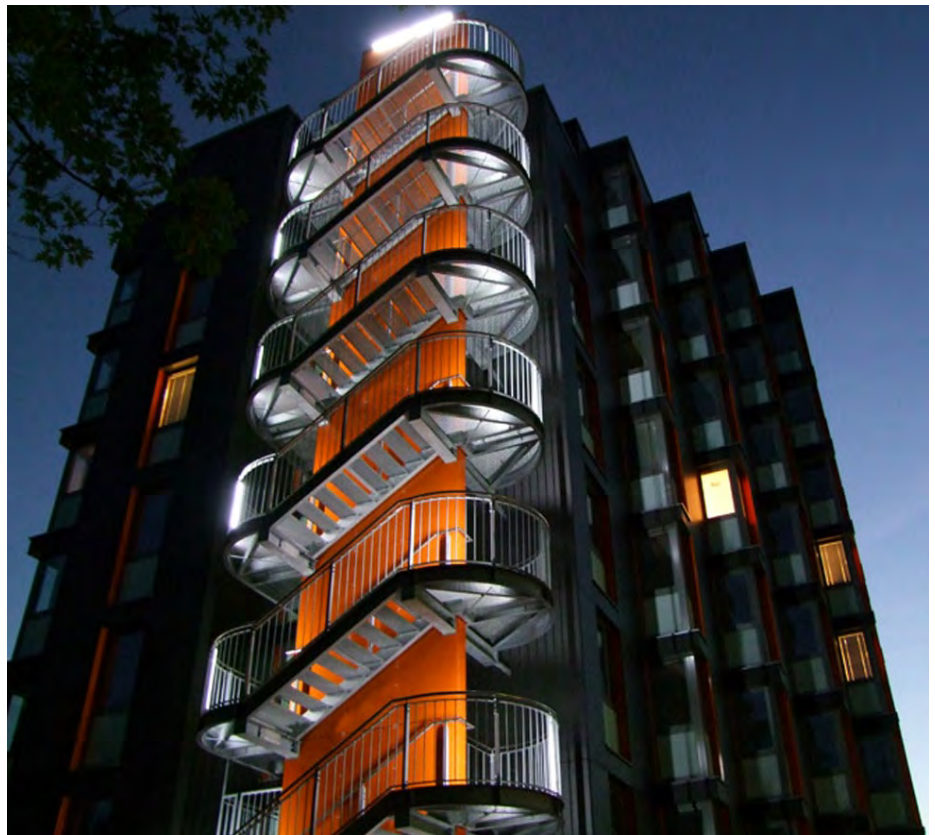
Einleuchtendes Design: Das Fluchttreppenhaus am Bochumer Studentenwohnheim Laerholzstraße / Auf der Papenburg wurde von den Architekten Krampe · Schmidt in Signalfarben gestaltet. Foto: Krampe · Schmidt
